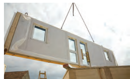
Fig. 62 – Construirea unei case modulare din materiale lemnoase
