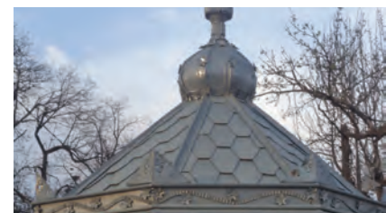
Fig. 35 – Îneltoare acoperiș din tablă zincată cu ornamente dantelate
