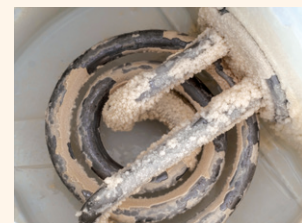
Apa dură provoacă depunere de calcar pe piesele mașinii de spălat
