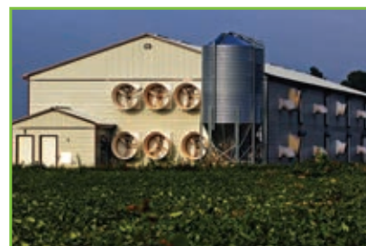
Fig. 6 – Fermă modernă de păsări, utilată cu ventilatoare și instalație de încălzire
